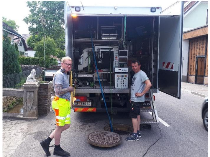
Im Auftrag des Abwasserverbandes wurden alle Hausanschlusskanäle mit der Kamera befahren und auf Fehlan schlüsse und Schäden überprüft
