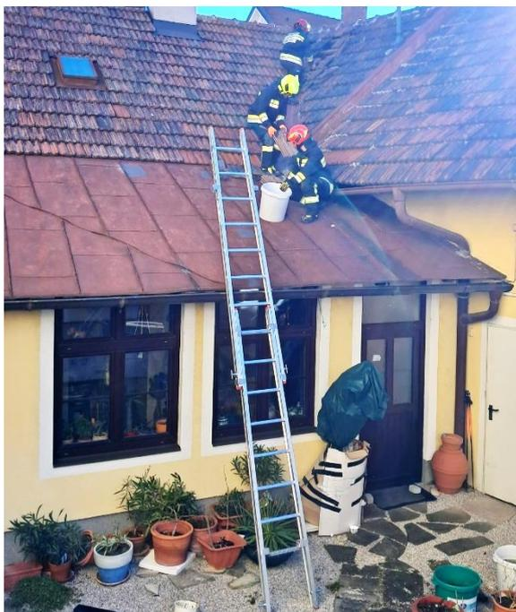
Am 3.2.2024 wurde bei einem Wohnhaus aufgrund starker Sturmböen das Dach teilweise abgedeckt. Die Feuerwehr sicherte und verankerte die Ziegel wieder provisorisch.
