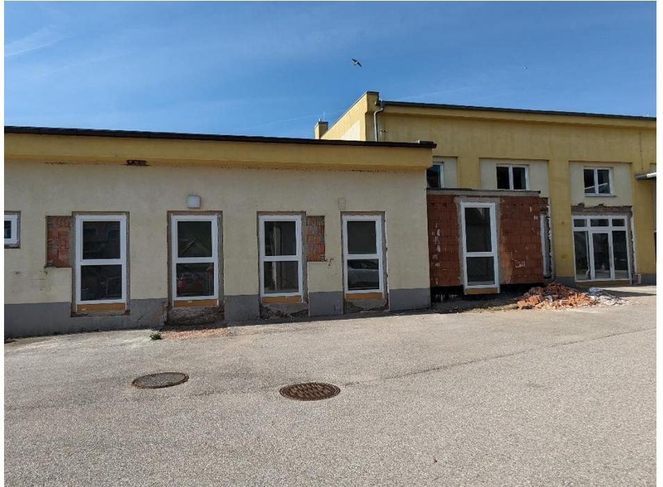
Die neuen Fenster und Türen sind bereits eingebaut. Als nächstes folgen nun die Gewerke Heizungsinstallation, Elektroinstallation und Innenputz. Im Außenbereich wird auch in Kürze mit den Fassaden- und Spenglerarbeiten begonnen.
