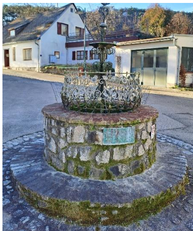
Der Brunnen vor der Steinsanierung
