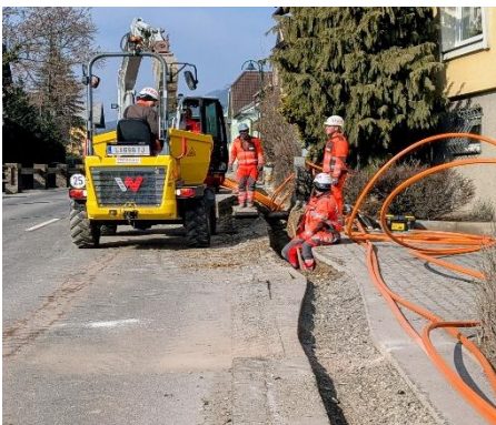
Die Grabungsarbeiten in der Puchberger Straße sind bereits erledigt
